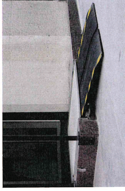
Rampe automatique encastrable dans le seuil de porte (dépliée sur le domaine public)
