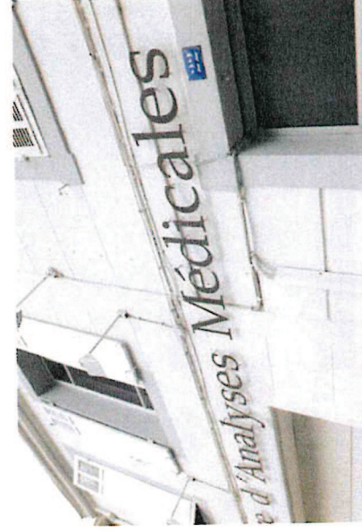
Lettres découpées sur bandeau transparent révélant la façade
