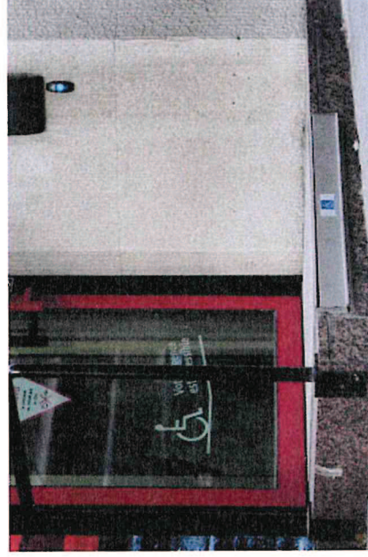
Rampe automatique encastrable dans le seuil de porte (repliée)
